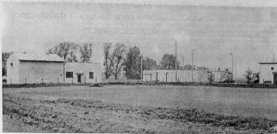
Oczyszczalnia ścieków w Pępowie
